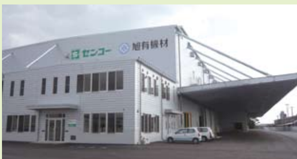
完成した新倉庫
