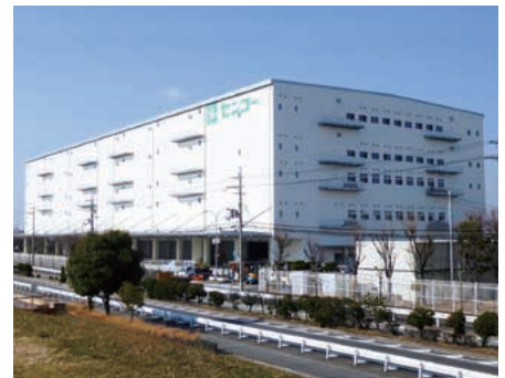
定温、防虫防塵、セキュリティ設備、免震機能を備えた 北大阪PDセンター(メディカル配送センター)
