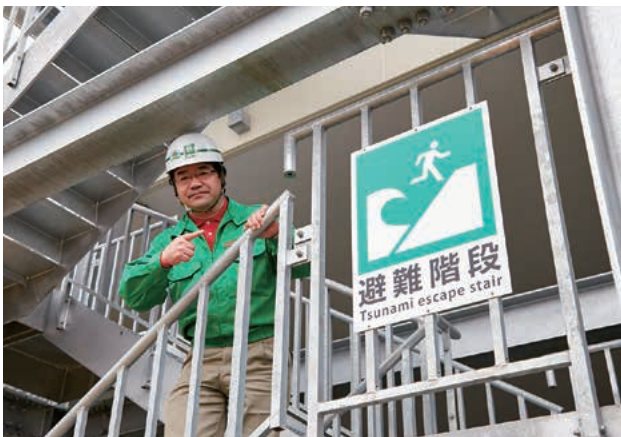
緊急時に外から上がれる避難階段を設置
