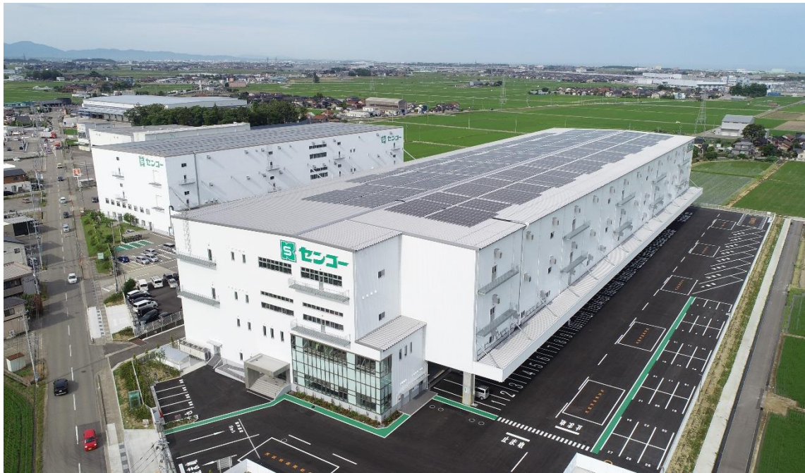
センコー金沢第2PDセンター外観
