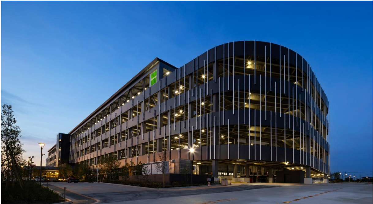
常総PDセンター外観
