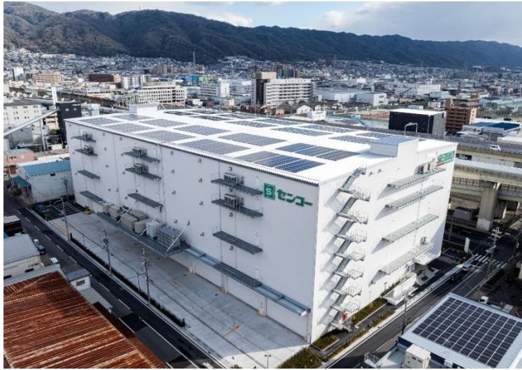
センコー東大阪第2PDセンター外観
