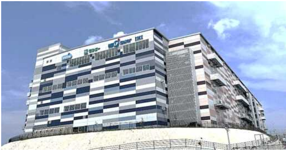
ウエルシア西関東 RDC
