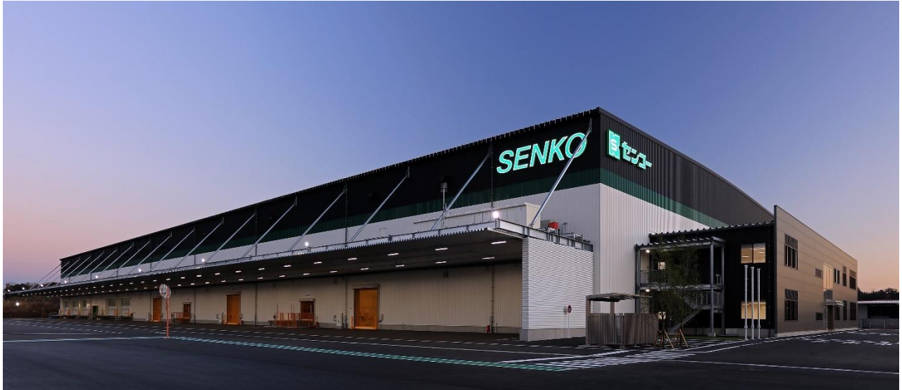
京葉PDセンターの外観
