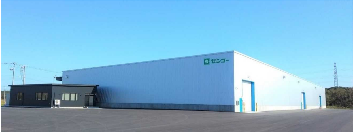
苫小牧車両センター外観
