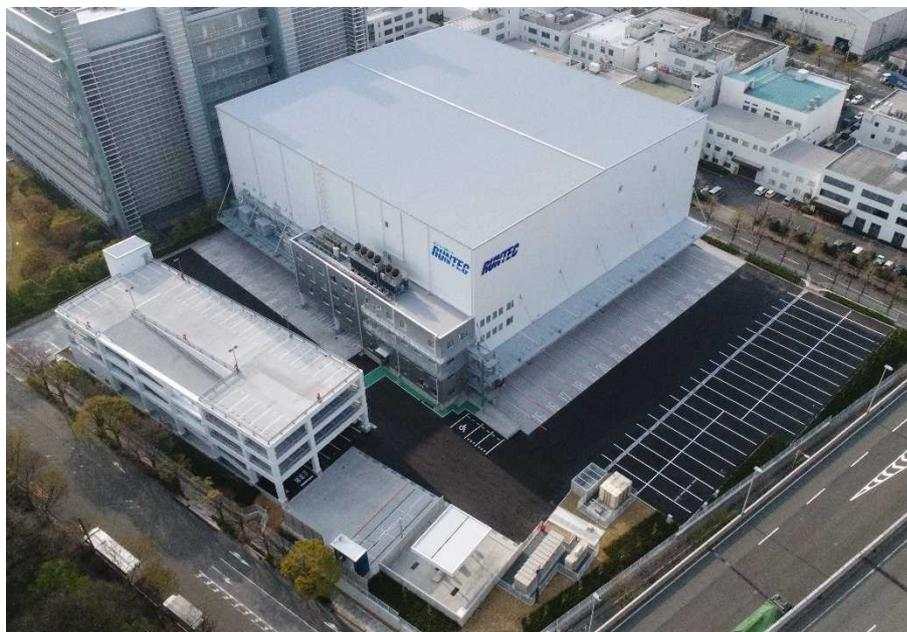
32台接車可能なトラックバースはドックシェルターを設備し、保管商品が外気温に触れることなく荷捌きが可能。また、自動倉庫には約6,100棚、4層の冷凍冷蔵庫には約5,000棚、計11,000棚をロケーション管理し、荷物用エレベーター1基と垂直搬送機3基により、荷役効率の向上を図っています。
