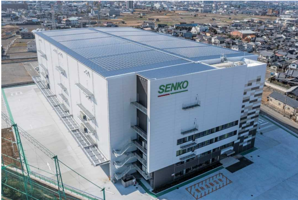
センコー泉南PDセンター外観
