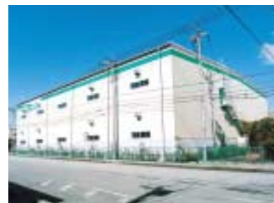
新富士PDセンター3号倉庫
