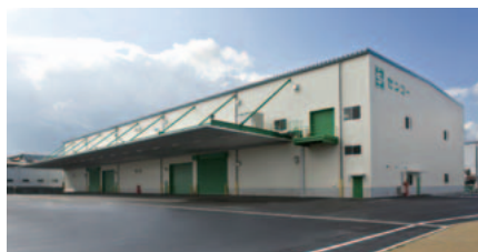
完成した奈良第3PDセンター
