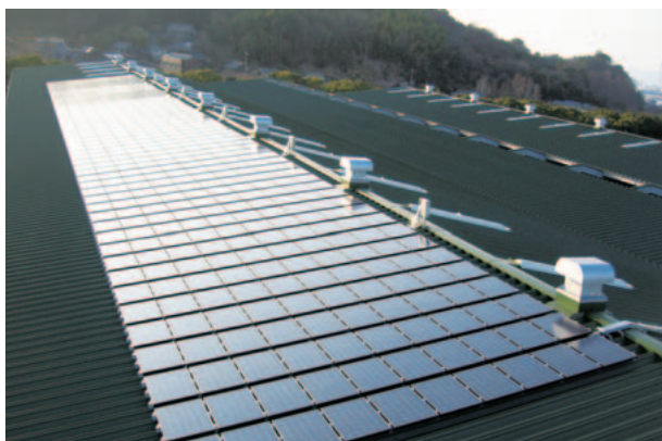
太陽光発電システムを導入した水島第3物流センター
