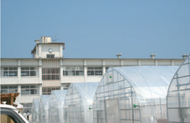
グラウンドに設置した水耕栽培のビニールハウス
