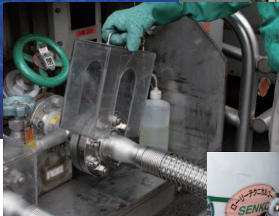
液体などの飛散を防止するフランジカバーを導入
