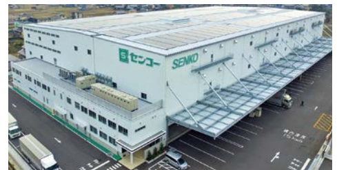
新電力会社と協業して太陽光自家消費を開始した岐阜羽島PDセンター
