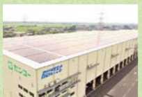
PDセンターでの太陽光発電・省エネ設備の導入
