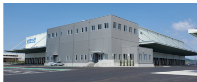
2020年4月稼働の(株)ランテック 門司支店
