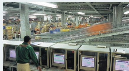
物流センターに大型で高速な自動仕分け機を導入
