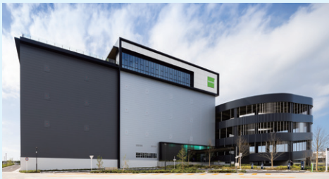
印西第2ロジスティクスセンター
