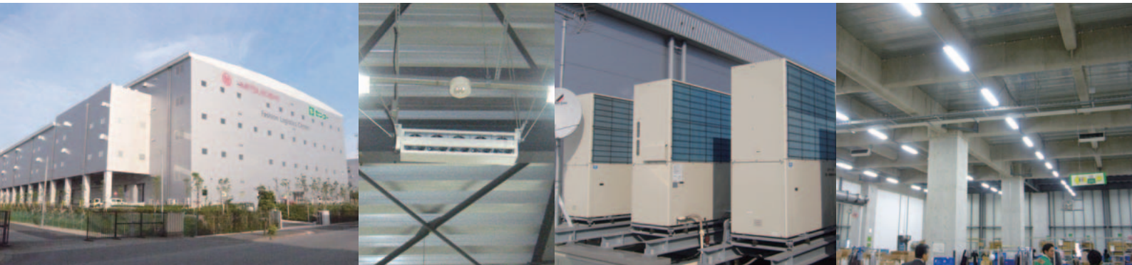
船橋ファッションロジスティクスセンター
