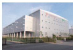
船橋ファッションロジスティクスセンター
