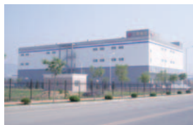
大連三興物流有限公司第1期倉庫
