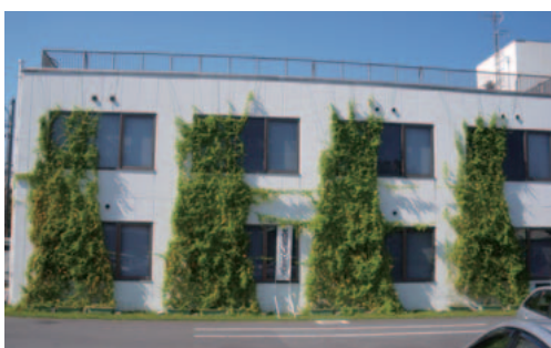
各地の事業所で実施されたゴーヤカーテンは夏場の節電に効果を発揮しました
