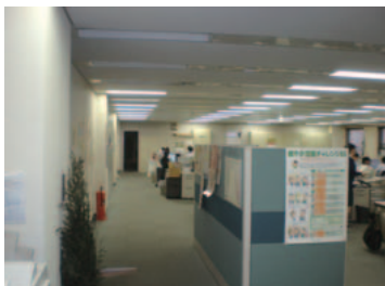
間引きされた事務所の蛍光灯
