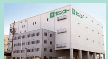
名古屋第2PDセンター (2014年10月稼働)
