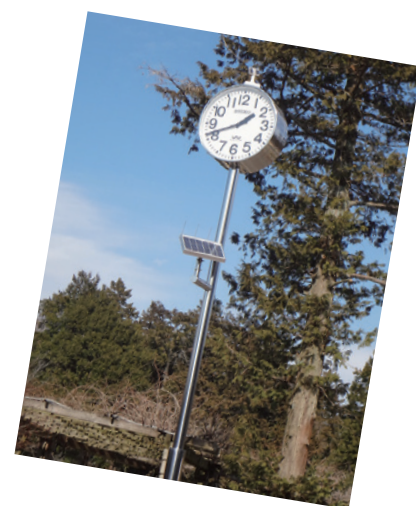
古河市の公園に時計塔を設置
