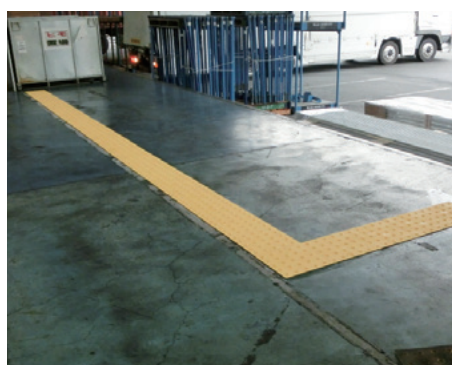
ホーム墜転落防止点字ブロック
