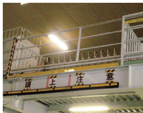
開口部墜転落防止対策
