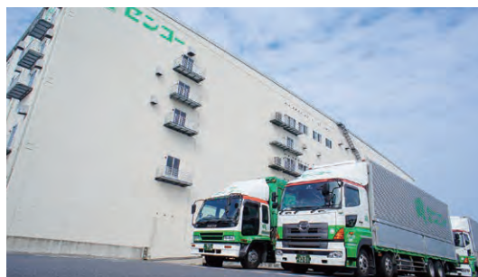
助成金を活用して100%LED照明化を達成した、浦和PDセンター
