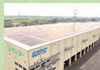
PDセンターでの太陽光発電・省エネ設備の導入
