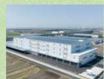
PDセンターでの太陽光 発電・省エネ設備の導入
